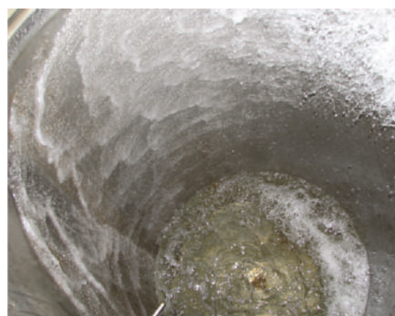
образование тонкой пленки на стенке деаэратора
