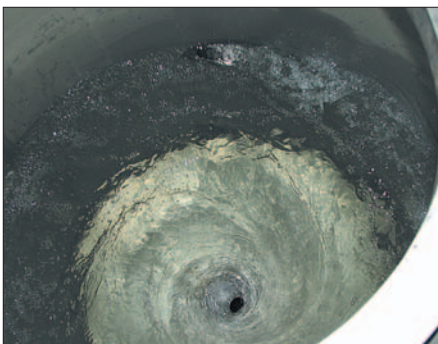
Рис. 6. Вид характерной глубокой воронки, способствующей подхвату воздуха откачивающим насосом
